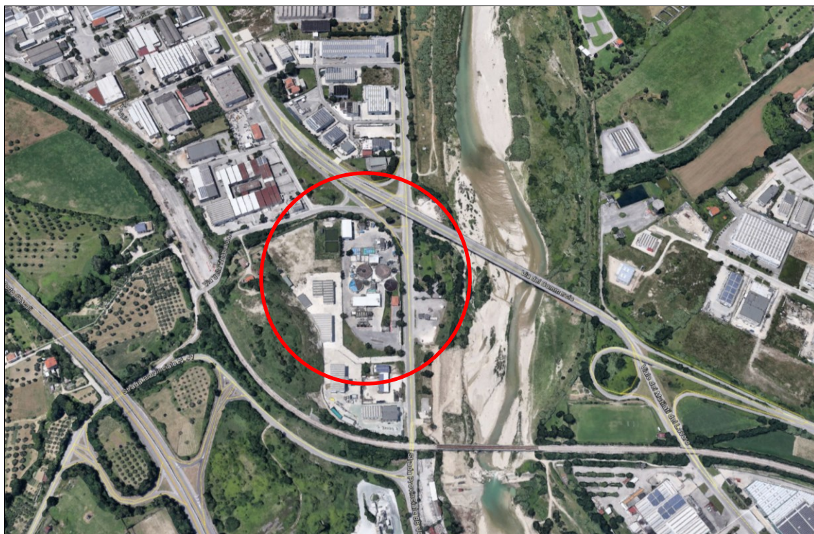
Figura 5.2.3 - Aerofotogrammetria dell'installazione IPPC.
