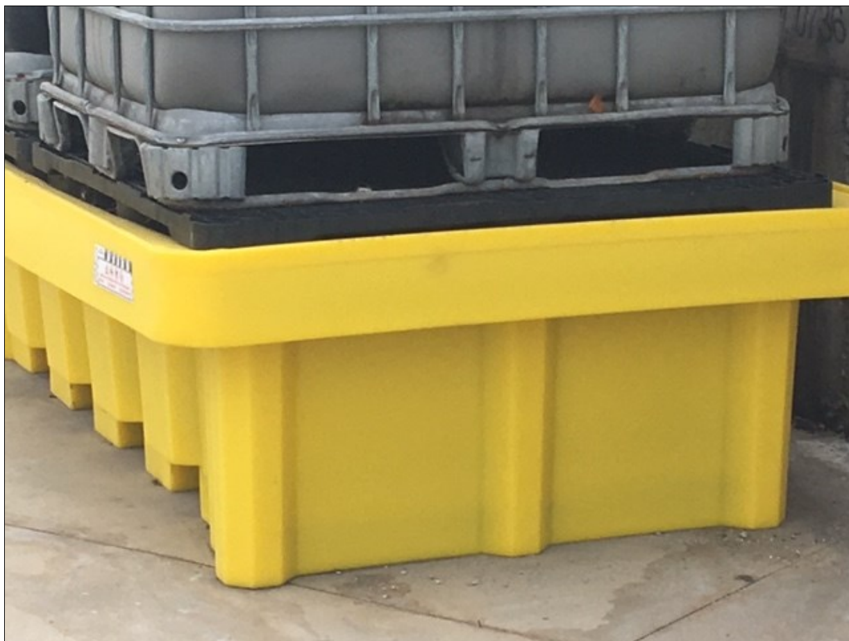
Figura 7.3.4 - Particolare dei bacini di contenimento utilizzati per le cisternette.
