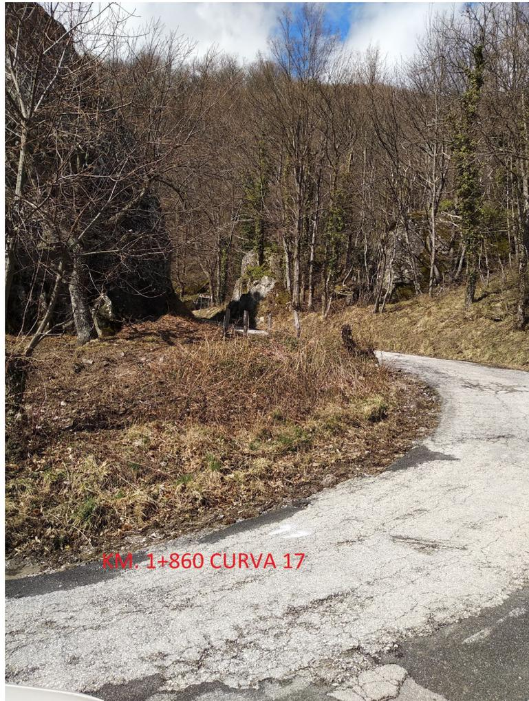
*Allargamento di n. 22 curve di valle attraverso la sistemazione della zanella esistente per la larghezza di 50 centimetri*
